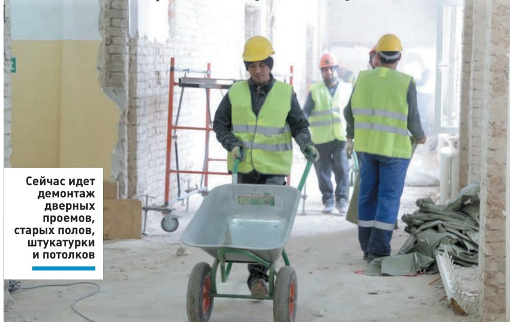
Сейчас идет демонтаж дверных проемов, старых полов, штукатурки и потолков
